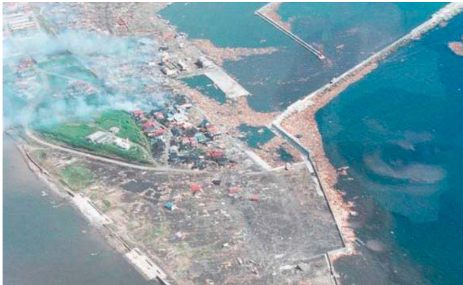
平成5(1993)年 北海道南西沖地震の津波・火災被害
