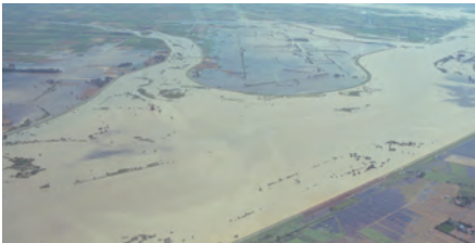
昭和56年(1981年) 台風に伴う大雨ではん濫した石狩川 出典: 石狩川昭和56年8月洪水報告書 提供: 北海道開発局
