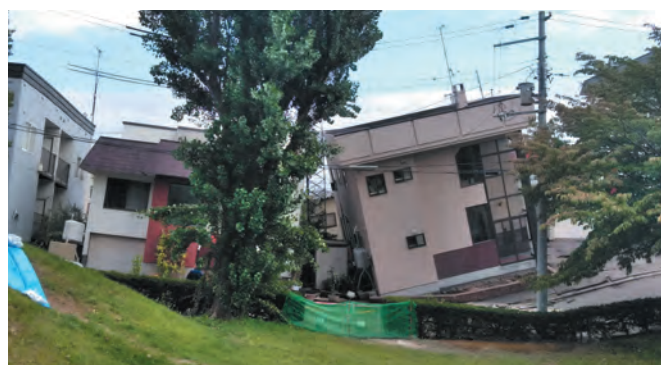
平成30年(2018年)北海道胆振東部地震 液状化現象
